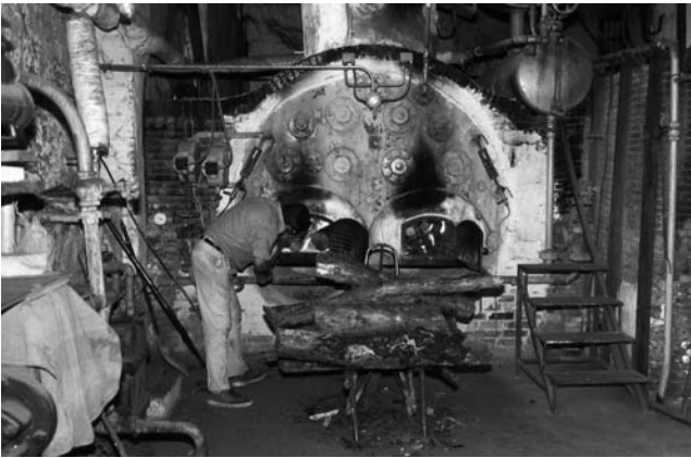
Caldera de la fábrica Ntra. Sra. del Carmen de Frigiliana (foto R. Marín)
