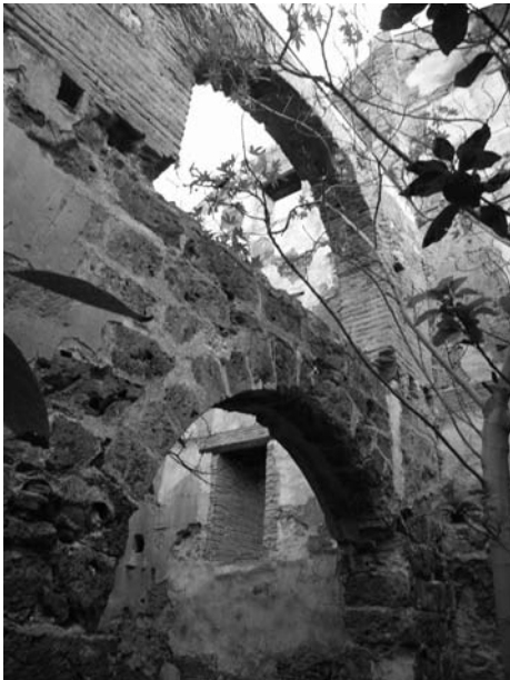
Arcos en el interior del ingenio de Armengol (foto R. Marín)
