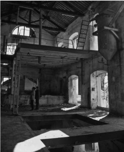
Interior del edificio principal de la fábrica de Torre del Mar tras su cierre (foto R. Marín)
