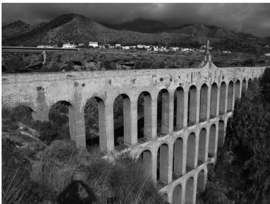
Acueducto del Águila (foto R. Marín)
