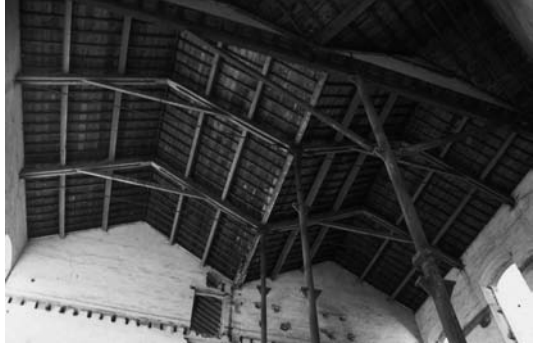
Detalle de las cubiertas del ingenio de Torrox (foto R. Marín)
