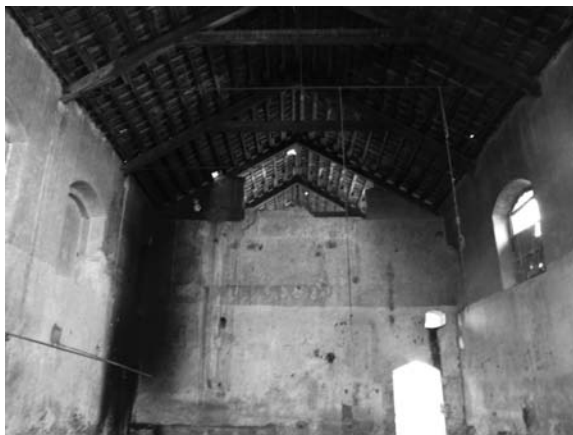
Interior de una de las naves del ingenio de San Joaquín (foto R. Marín)
