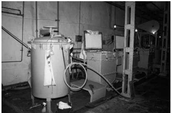
Pailas y calderas de cocción de la fábrica Ntra. Sra. del Carmen de Frigiliana (foto R. Marín)
