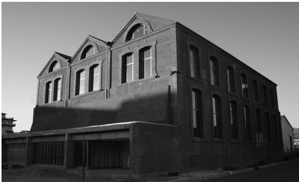
Edificio principal de la fábrica de Torre del Mar tras su restauración (foto R. Marín)
