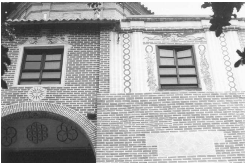
Parroquia Santa María de la Victoria. Muros exteriores de Sacristía y Camarín. Detalle (foto G. Segarra).
