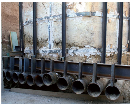
Lám. 41: Detalle de la estructura metálica colocada como preliminar a la extracción, traslado y futura musealización del horno.
