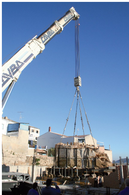
Lám. 42: Traslado del horno.
