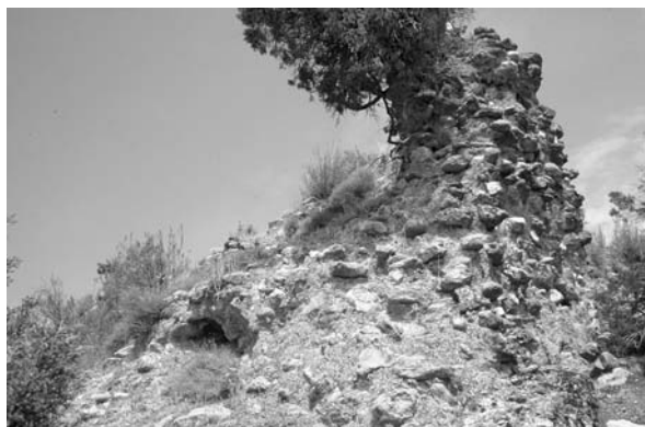
Lámina 20. Vista de los escasos restos de la torre superior de la fortaleza denominada "Castiello" (término de Secastilla, Huesca), identificado tradicionalmente como "Castro Muñones". Obsérvese la fábrica de mampostería encofrada de esta torre, que difiere totalmente de la muralla, con un paralelo en la fortaleza de Castro (La Puebla de Castro, Huesca).
