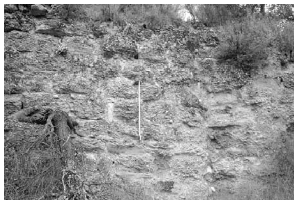
Lámina 19. restos del lienzo principal de la muralla de sillares de conglomerado de la fortaleza denominada "Castiello" (término de Secastilla, Huesca), identificado tradicionalmente como "Castro Muñones".
