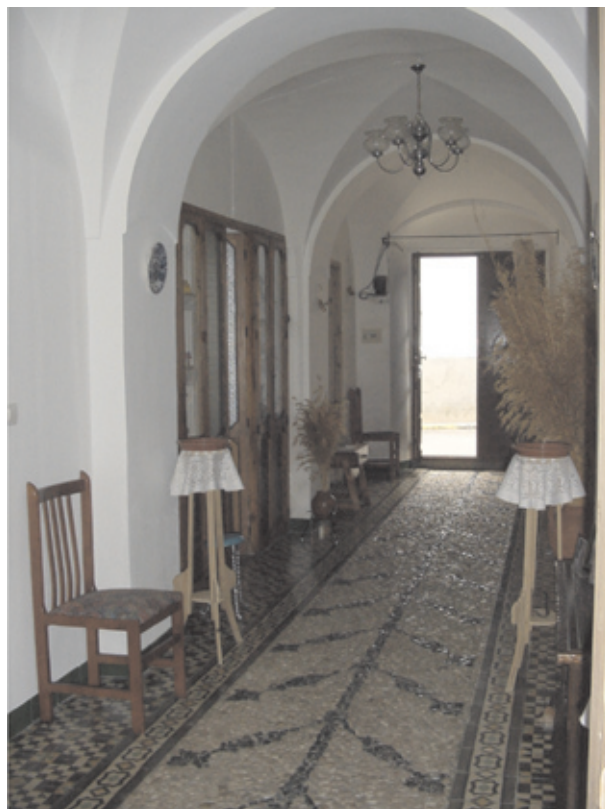
Ejemplo de mosaico pétreo o vereda a base de piedras filonianas, obtenidas como escoria de la fundición de plata y plomo, y de desbastar piedras con alto contenido cuarzoso.
