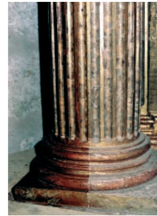
Figura 19. Proceso de limpieza en una de las columnas.
