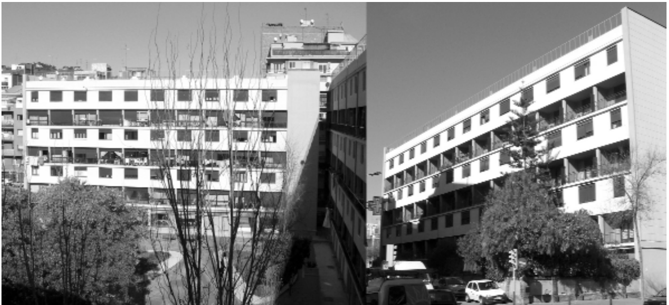
Casa Bloc. Dos criterios de restauración diferentes, a la izquierda, la consolidación del cierre de las terrazas; a la derecha, la recuperación de la morfología original.
