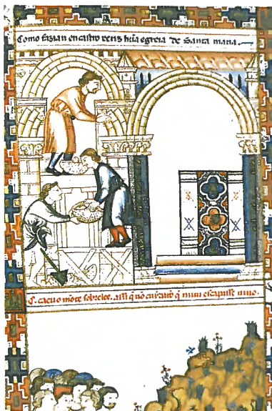
10.-Cantigas de Santa María, Florencia, Biblioteca Nazionale, ms. B.R.20, f.82, cantiga 252, viñeta a, obreros y andamios en la iglesia de Castrogeriz.
