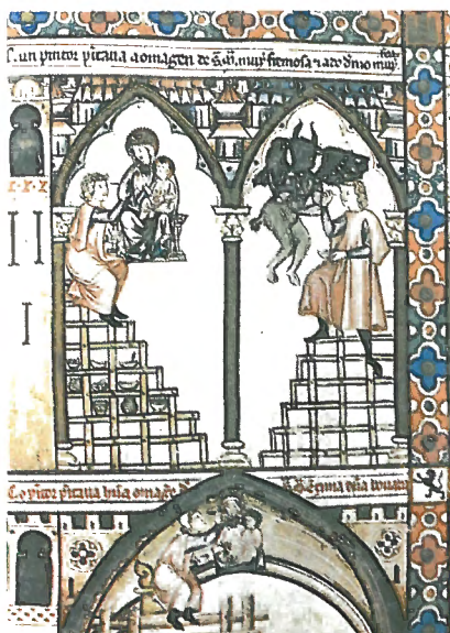
17.-Cantigas de Santa María, Escorial T.I.1., cantiga 74, viñeta a, pintor que hacía a la Virgen muy hermosa y al diablo muy feo trabajando desde un andamio escalonado.
