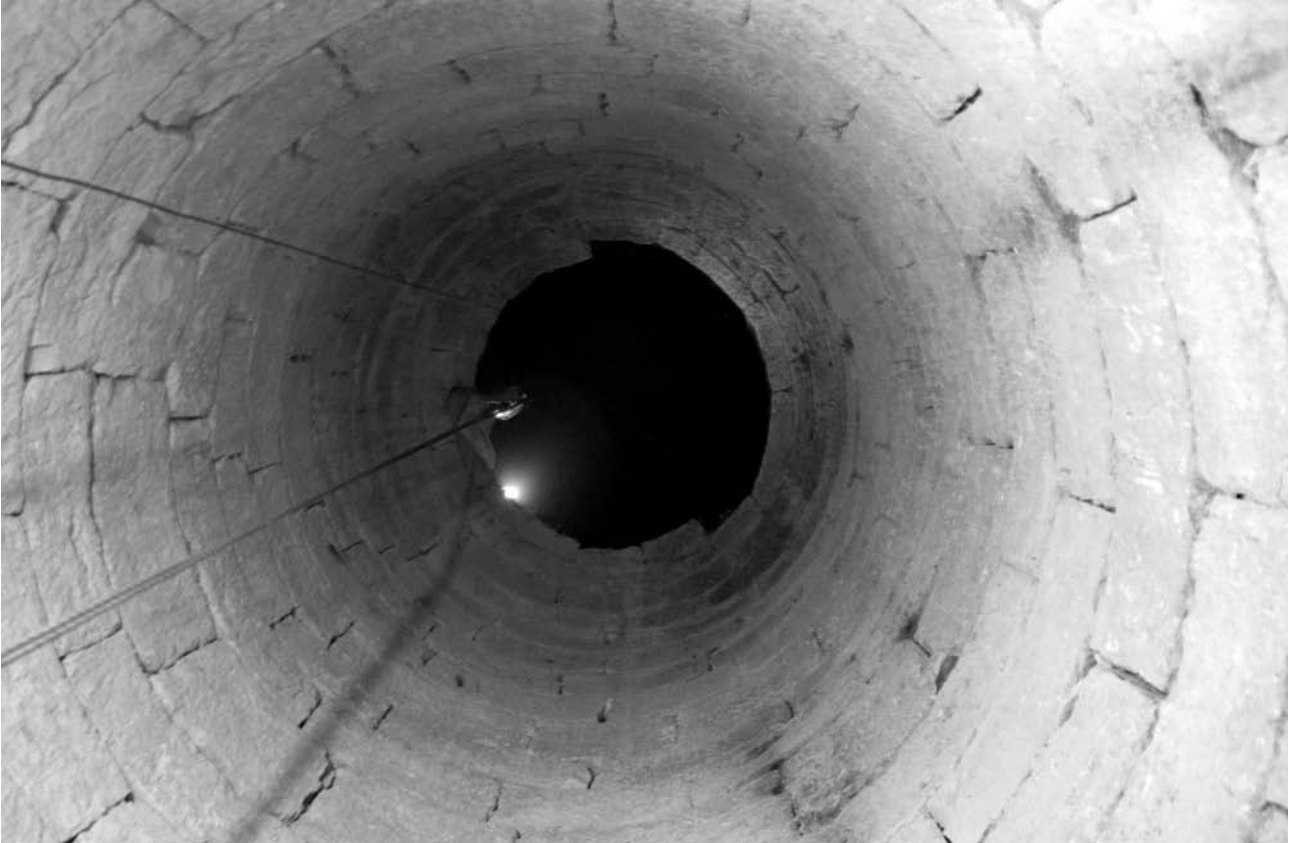
Interior del pou de la base de la torre.
