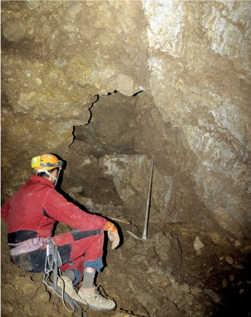
Fig. 7. "Falla normal" identificada en las paredes de la dolina 8 que evidencia la generación de colapsos kársticos controlados estructuralmente durante el depósito de la terraza del Barranco de Sotillo en el que se encuentra la dolina (12 de noviembre de 2004). Se observa un bloque de caliza anguloso en el interior del depósito de terraza asociado al plano de rotura.
