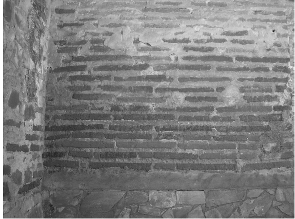
Aparejo de ladrillo en la fábrica de la iglesia
