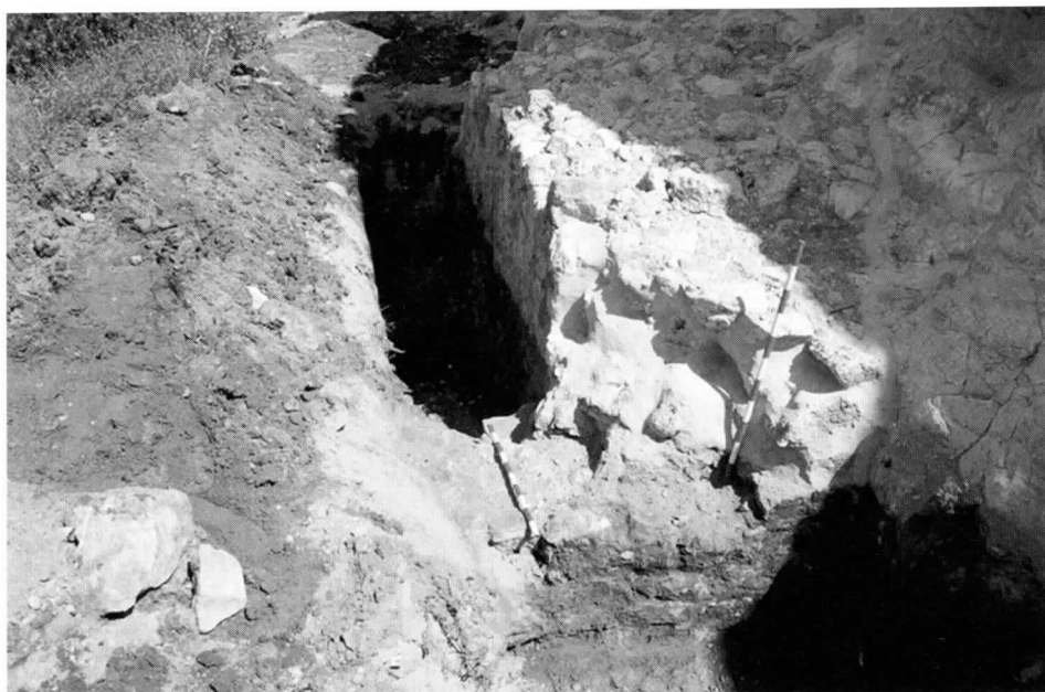
LÁM. 4. Estructura adosada a la base de la muralla
