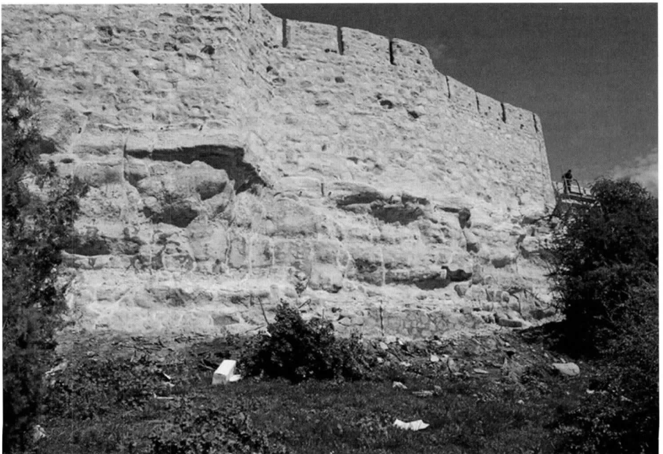
LÁM. 3. Tramo de muralla del primer recinto de la fortificación zamorana, consolidado en la presente intervención
