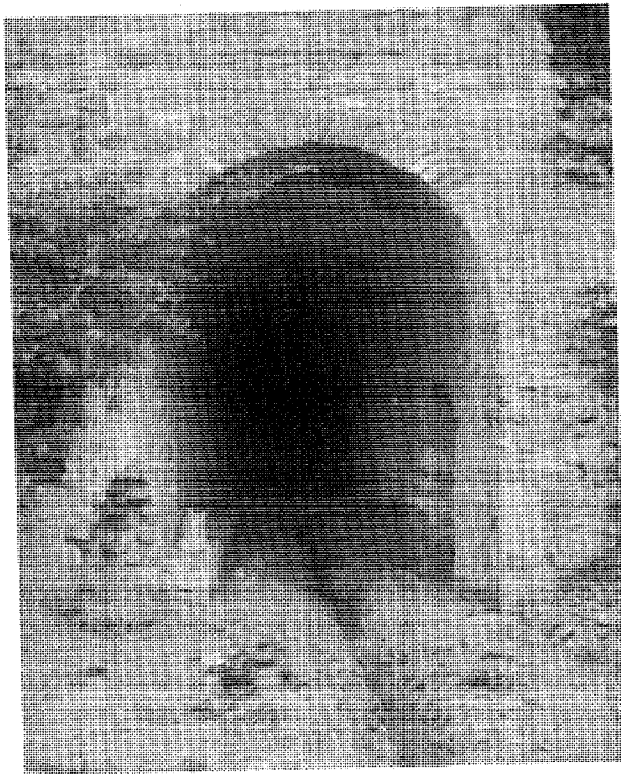
Fig. 5: Estado actual de los "sudaderos". (2002).
