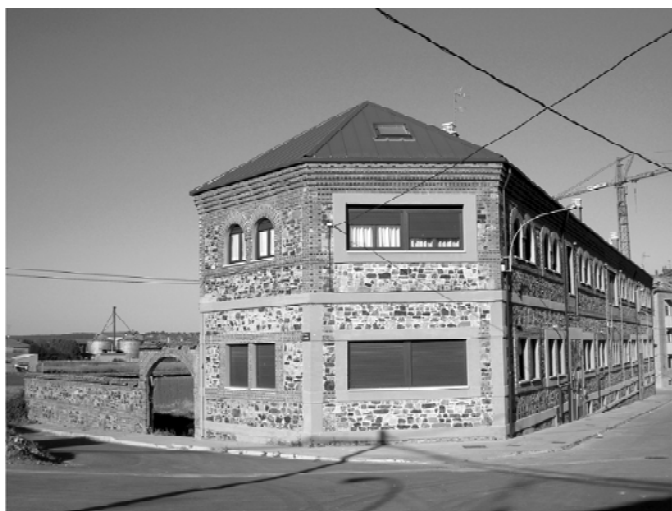
Antiguo almacén con arquitectura de carácter industrial rehabilitado para la creación de viviendas
