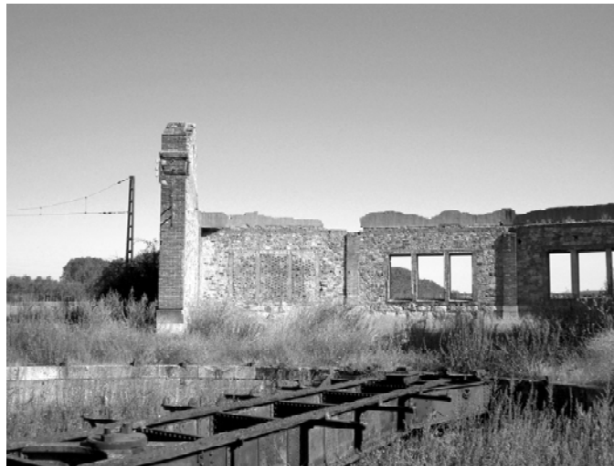
Zona técnica de la Estación. Máquina rotatoria para girar locomotoras y edificio anexo derruido. Justo detrás se encuentran los edificios de los trabajadores en semejante estado
