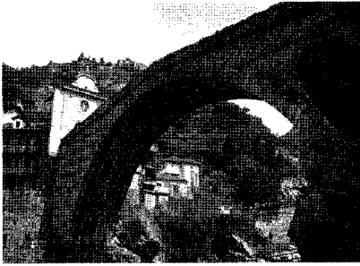
Figura 6.- Pont de sant Martí d'Aosta
