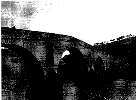
Figura 4.- Pont de la Reina
