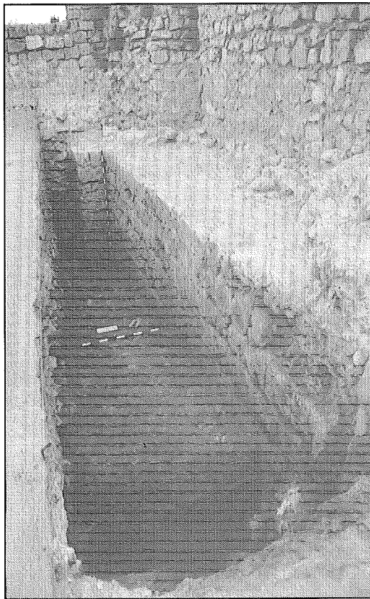
Sondeo 2. Engrosamiento de la muralla de mampostería del siglo XIII, actual cierre del castillo por ese sector. Está realizado con sillarejos de travertino, en los que se aprecian algunas marcas de cantero (siglo XIV).
