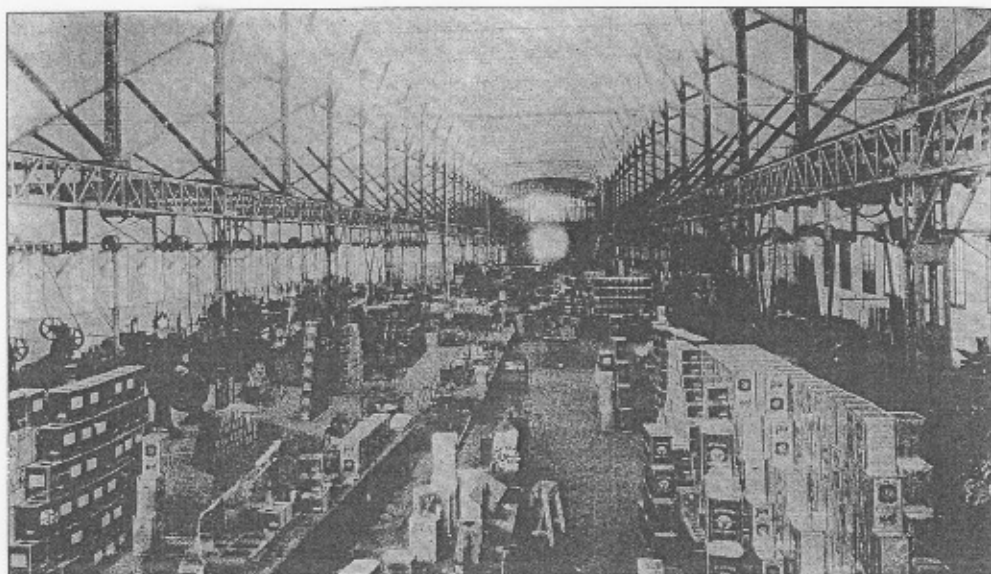
Interior de la nave derecha destinada a la fabricación de envases metálicos.
