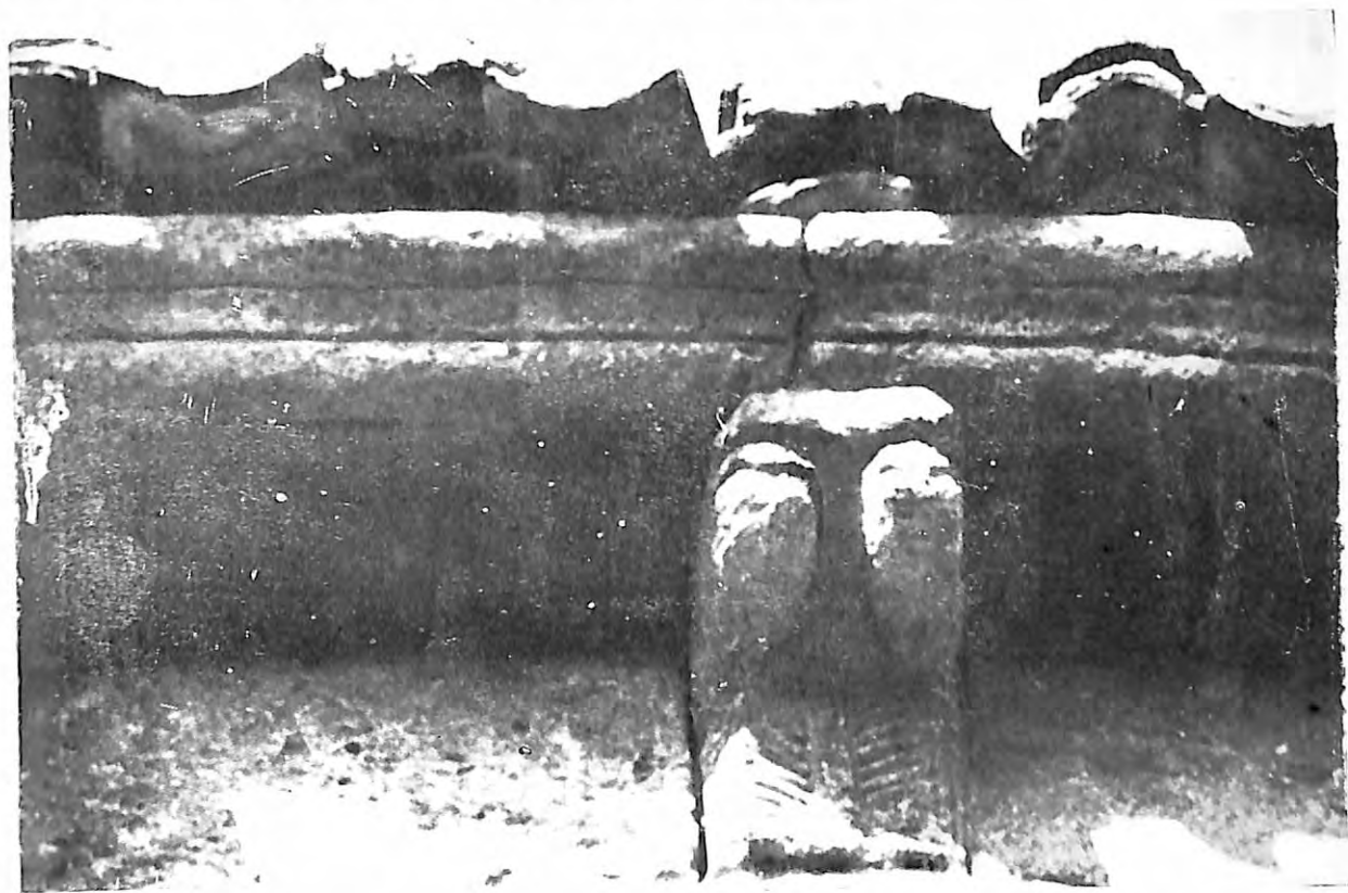
LAM. II. Trigueros del Valle. Detalles del ábside de la iglesia. (Fot. del S. E. A. A.)
