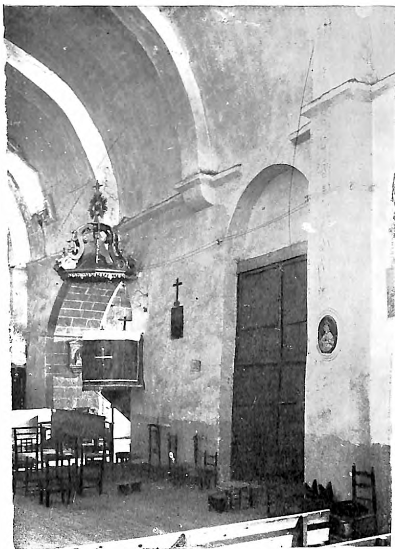
L. A. M. V. Iglesia de Trigueros. Interior de la nave (Fot. del S. E. A. A.)
