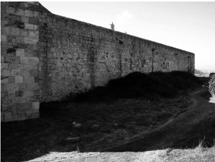
Lám. I. Diversas vistas de la liza antes del inicio de los trabajos: 1. Zona 9; 2. Zona 10.
