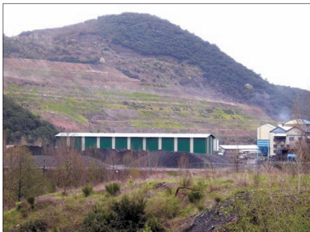
FIG. 5. Explotación minera de carbón en el municipio de Toreno. Obsérvese como en la ladera degradada por la actividad extractiva se han realizado labores de restauración ambiental.
