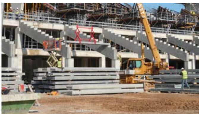
Figura 2. Obras de graderío de un estadio deportivo.
