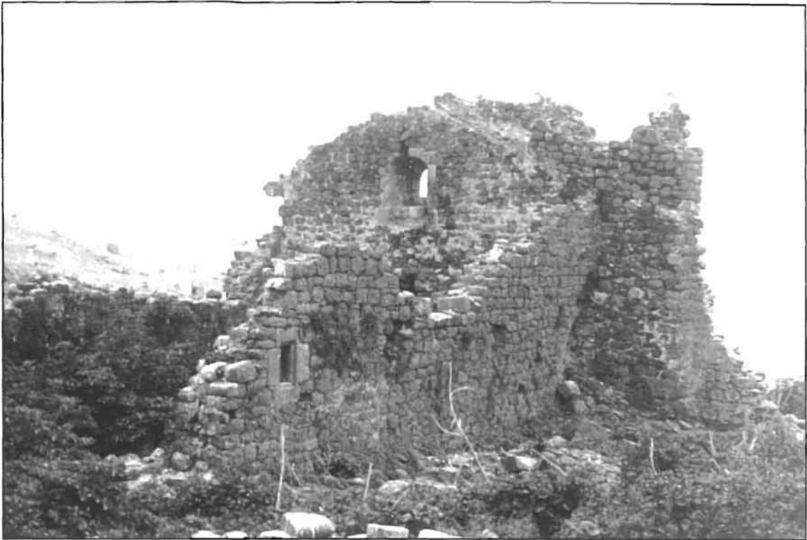
Fotografía 3: Restos arquitectónicos del convento.
