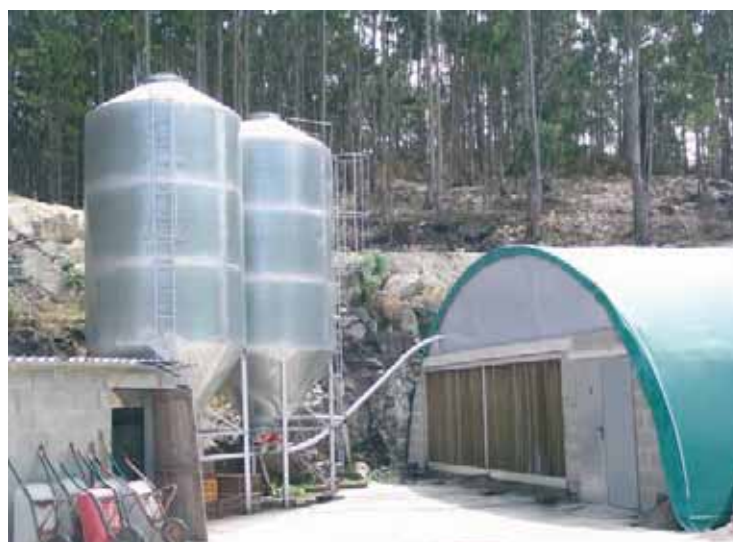
Foto 7: Las naves cuentan con unos grandes paneles acondicionadores del aire.
