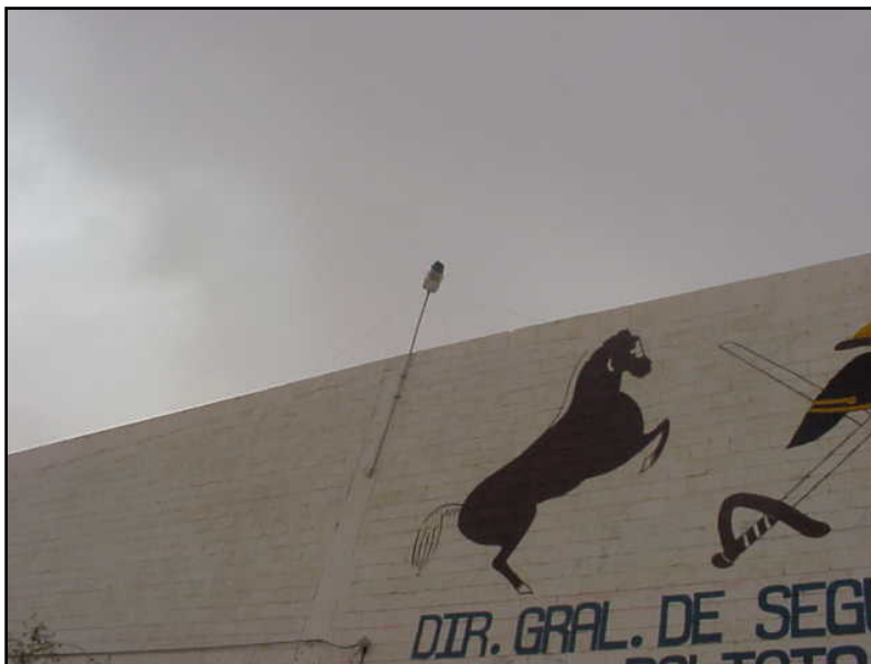
Fig. 10. Sensor de Estación de monitoreo Montada.
