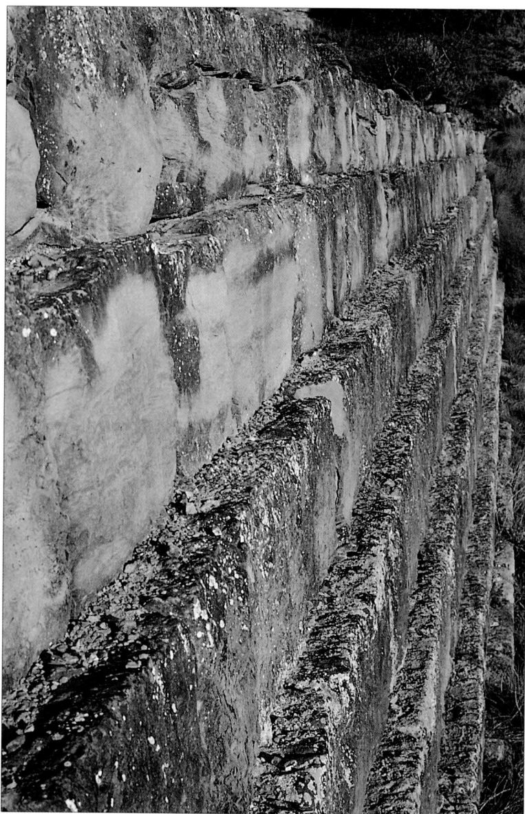
Mur de sosteniment.
