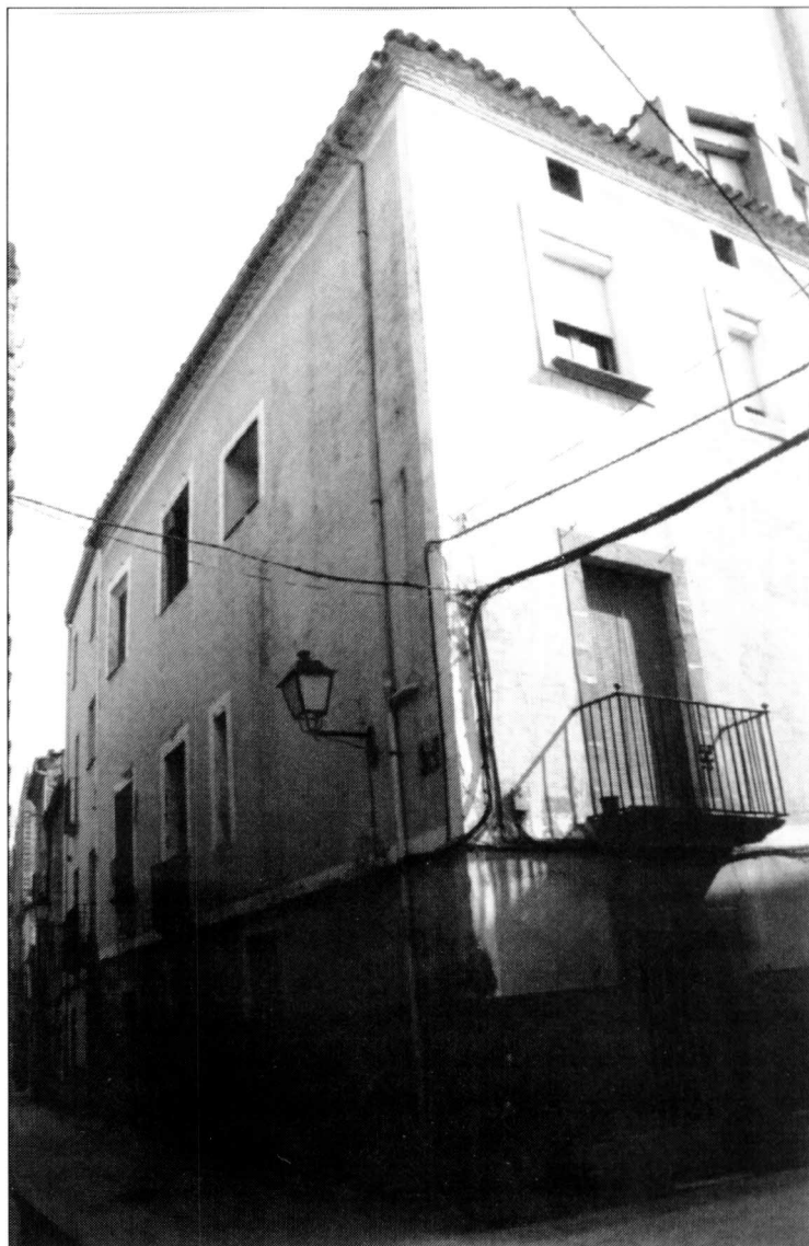
Vista del carrer de Lluís Folquier amb cal Ribera fent cantonada amb el carrer de la Font. A l'altra banda del Carrer Folquier, hi ha la part del darrere de cal Perelló. (Fotografia: Oriol Saula).
