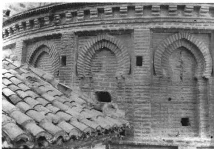
(Fig. 1) GUADALUPE. Monasterio. Registro superior del ábside mudéjar.
