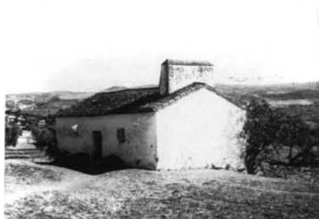
Chimenea transversal sobre el caballete de la cubierta en una edificación resuelta en bóveda. Jerez de los Caballeros.
