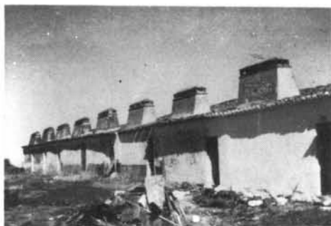
Secuencia de chimeneas a pequeños edificios. Olivenza.
