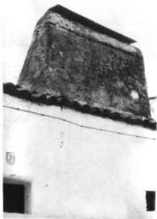
Chimenea con cubierta metálica. Peñalsordo.
