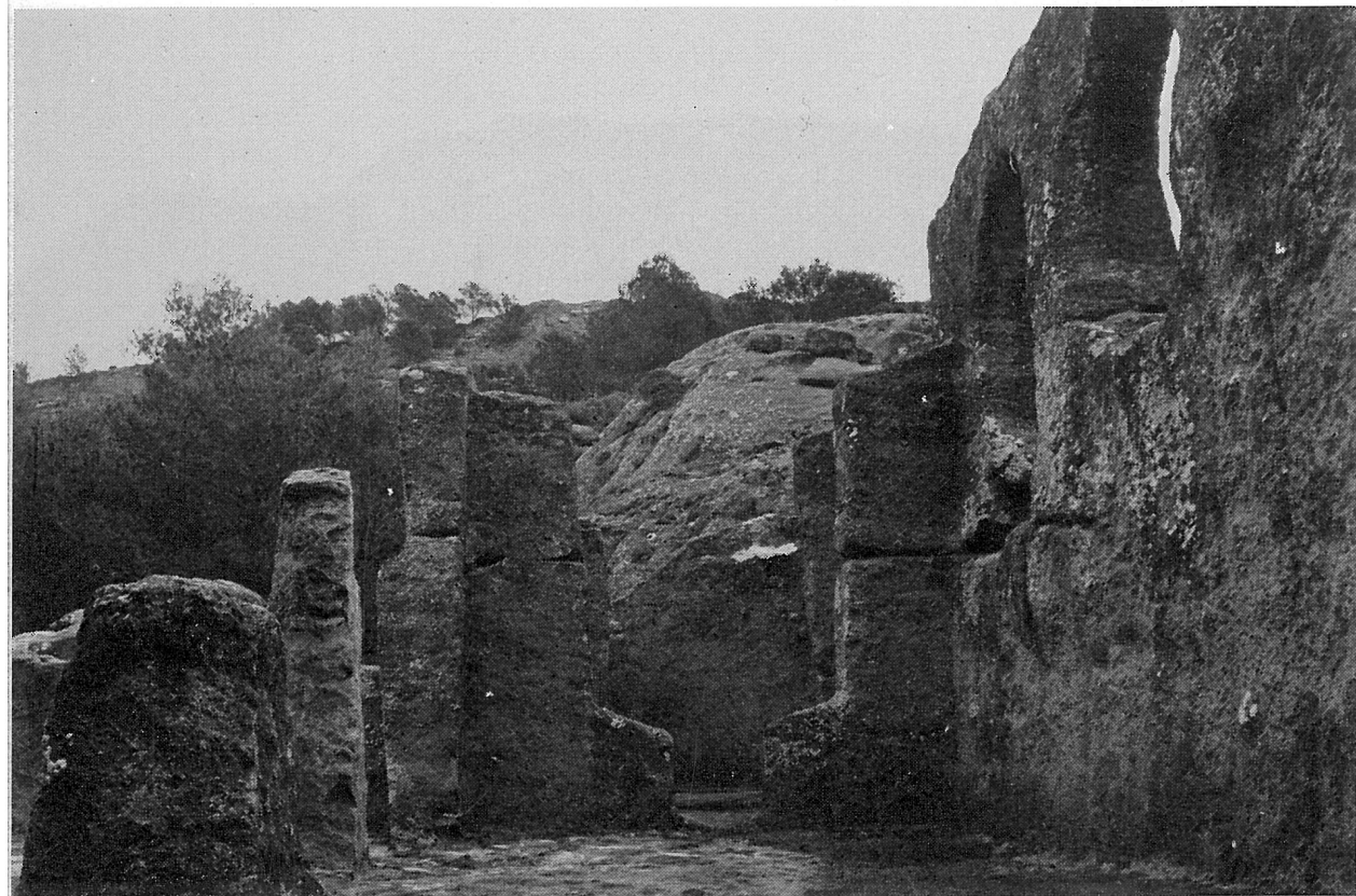
Lámina VII. Nave lateral izquierda, tomada desde el ábside
