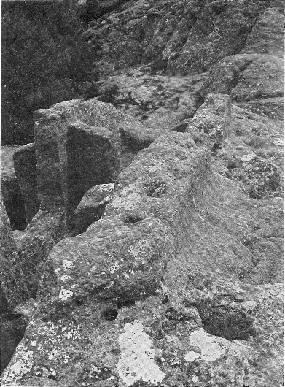
Lámina XV. Muro exterior de la nave lateral derecha
