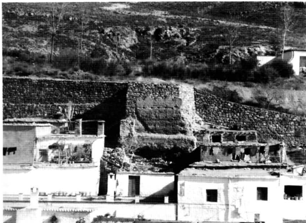
Fig. 4. Ḥiṣn de Laujar de Andarax: torre mediana oeste.
