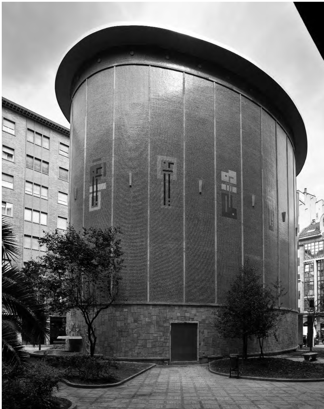
Figura 1. Vista exterior del edificio. Fotografía: Marcos Morilla
