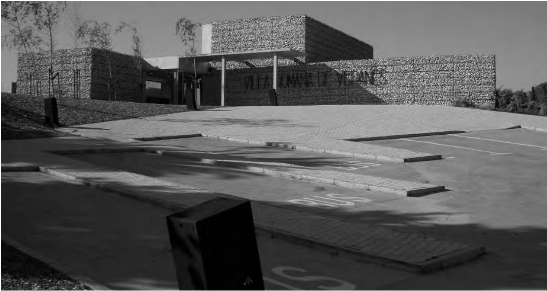
Figura 3. Fotografía del edificio de recepción visto desde el aparcamiento.
