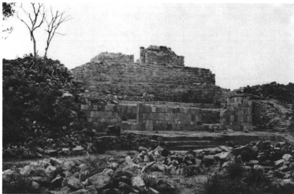
FIG 5.—La estructura palaciega DZ-15 a los pies de la pequeña pirámide DZ-8.
