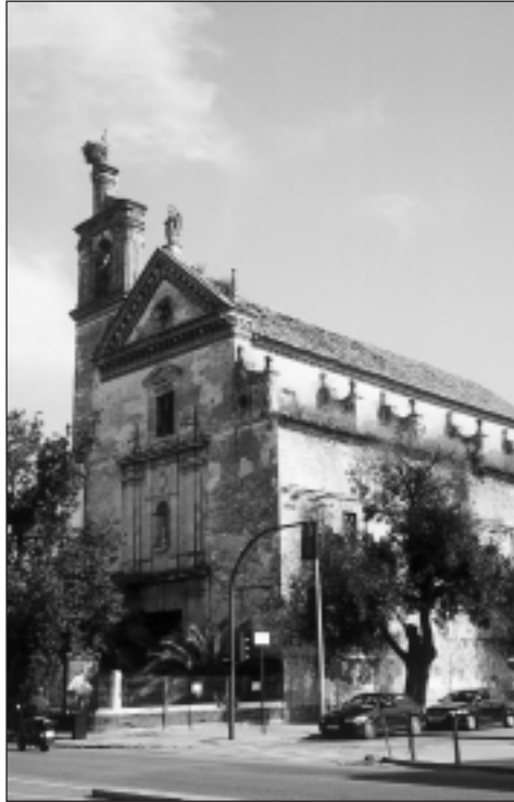
Exterior de la iglesia de Madre de Dios
