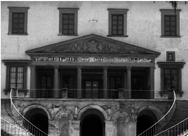
VILLA MEDICI EN POGGIO A CAIANO (G. da Sangallo)
