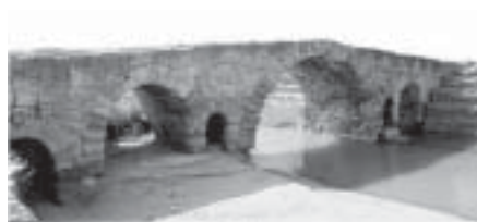
Foto del puente romano después de la inundación del año 1997
