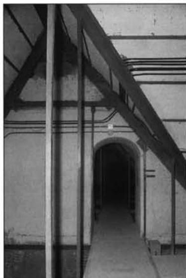
Hacia 1965 se sustituyó toda la techumbre original de madera de pino por perfiles metálicos laminados. Tan sólo queda madera de la estructura de techumbre original en una pequeña zona de la fachada del Monasterio.
