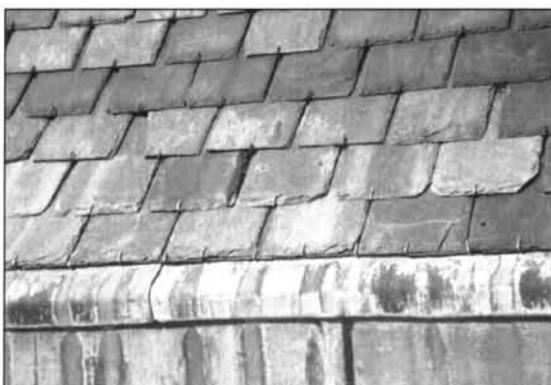
Los ganchos de sujeción de pizarra realizados en acero galvanizado producen problemas de oxidación frecuentes, y son sustituidos por ganchos de acero inoxidable.
