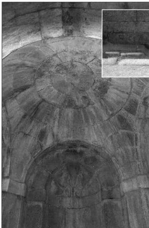
Todo el Jardín de los Frailes (fachadas sur y sudeste) tienen un sistema de desagüe mediante caceras y gárgolas. Sin embargo, la masa de tierra, rica en agua por el riego del jardín, afecta a la piedra de las escaleras y recintos abovedados que conducen al nivel inferior de la huerta.
