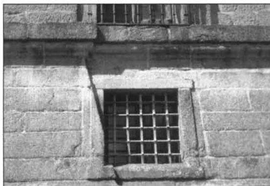
Las rejas metálicas de las ventanas de los pisos bajos han producido, al oxidarse y dilatarse, roturas en alfeizares y dinteles, con pérdida de volumen, en algunos casos muy notables.
