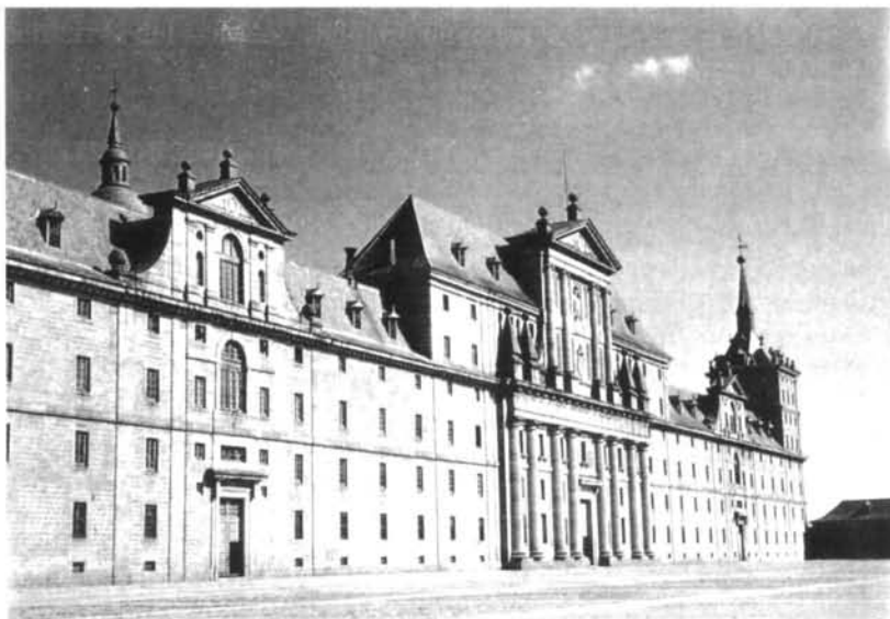
El Escorial, fachada principal.
