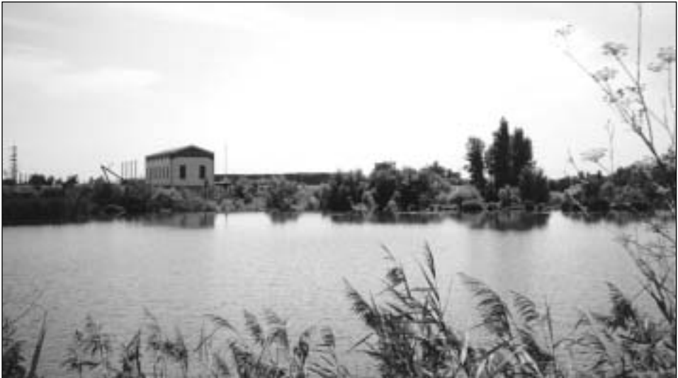
Figura 3.- Presa de Machín o de Rincón con las instalaciones de la Central Eléctrica de Azagra.
