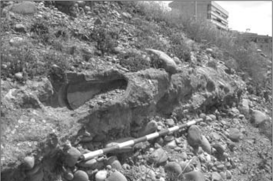
Figura 7.- Canalización de Minglanillos, bajo la calle Pintor Pradilla.
