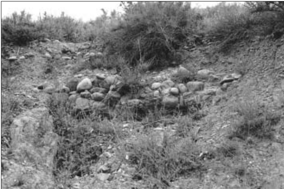
Figura 3.- Canalización revestida de canto rodado. (Foto Arturo Pérez).
