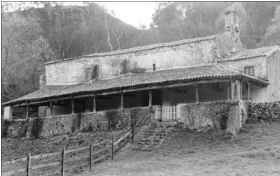
Figura 1.- Vista general de la ermita de San Emeterio en Pimiango.
