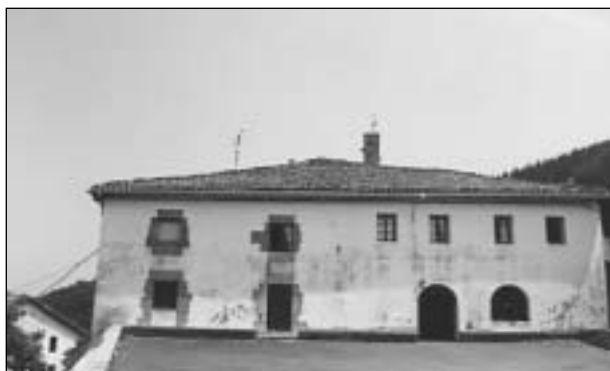
Foto 1. Fachada principal de la ermita de los Santos Emeterio y Celedonio (Azkoitia) adosada a la casa vicarial (situada a la izquierda, con ventanas de sillería).
