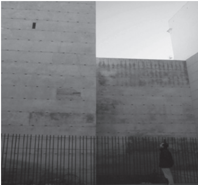
Tramo de la muralla árabe en C/ Carretería 62-64.
