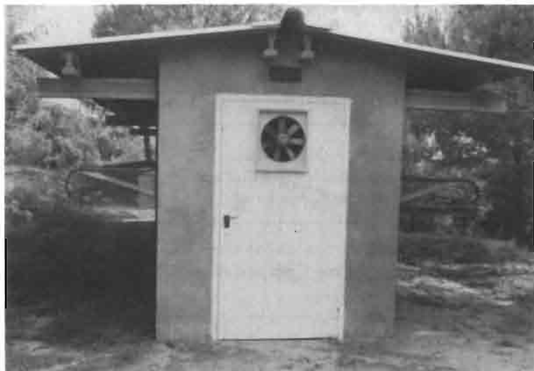
Detalle de la pequeña nave experimental
