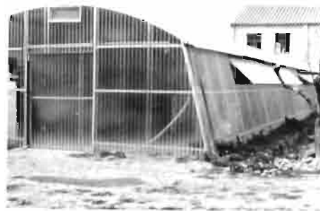
Nave tipo túnel nacional, con plástico aislado
