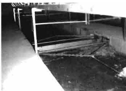
Limpieza mediante rastrillo mecánico o scraper
