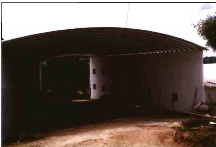
Fig. 2.- Detalle del acceso cubierto a la nave de ambiente controlado, con cubierta de plancha galvanizada.
