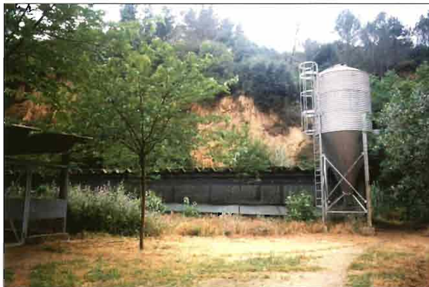
Vista exterior de una de las naves situada en medio del bosque y bien protegida de las inclemencias del tiempo.
