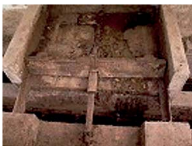
Figura 3: Pala de limpieza fija
