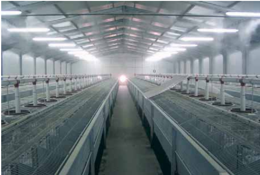
Las naves, de 13 m de ancho por 39 m, de largo están construidas con paneles de tipo sándwich.
